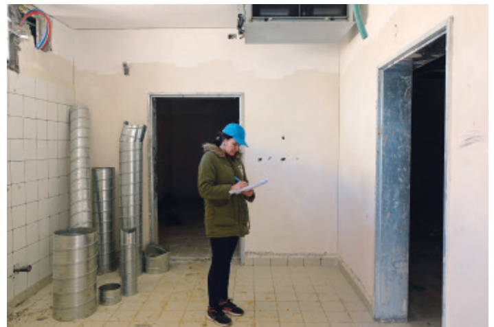
Kurz vor der Fertigstellung: das Gebäude für medizinischen Abfall neben dem Caritas Baby Hospital.
